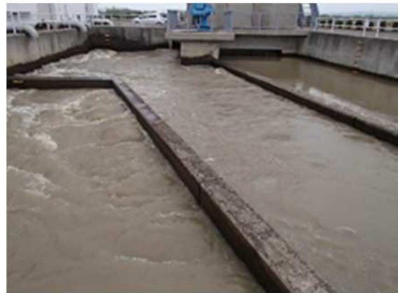
写真 干拓地排水の調査
