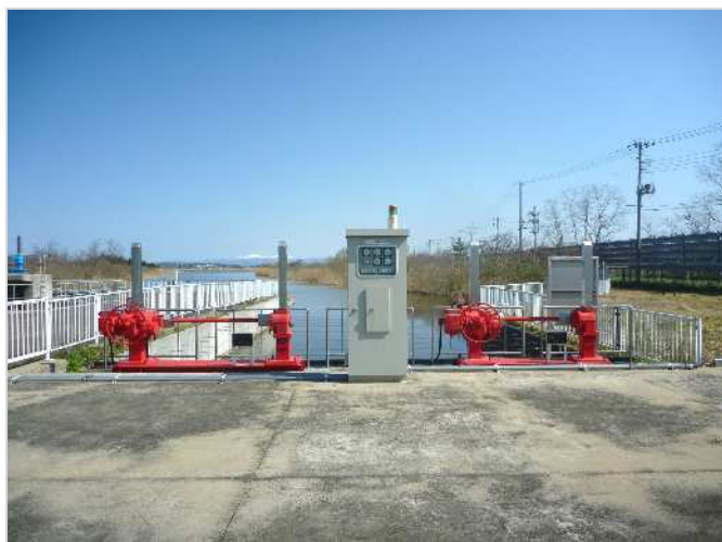
浜口機場生活環境部樋門
