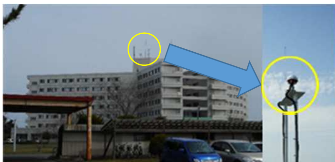
写真 RTK-GNSS の基準局
